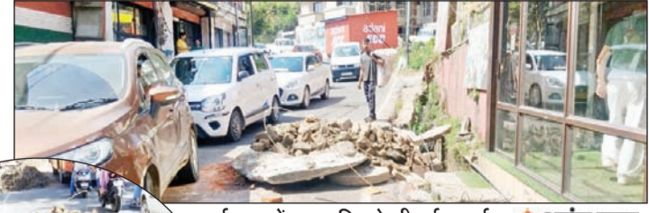
धर्मशाला में सड़क किनारे की गई खुदाई।
