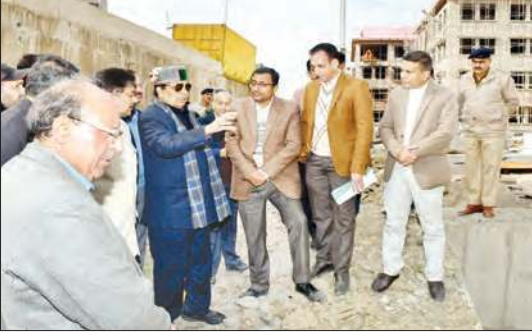
सोलन के कथेड़ में निर्माणाधीन अत्याधुनिक बहुउद्देशीय अस्पताल का निर्माण कार्य का निरीक्षण करते स्वास्थ्य एवं परिवार कल्याण मंत्री कर्नल धनीराम शांडिल।
