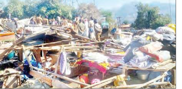
सोलन में रबोन के नजदीक अवैध तरीके से बनाई गई झुगियों को हटाने की कार्रवाई।
