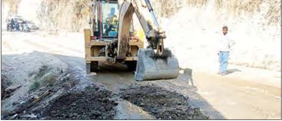
हमीरपुर–मंडी एनएच के फर्स्ट स्टेज में 1500 मीटर सड़क पीक्यूसी से निर्मित हो रही है।
