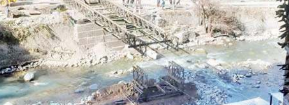
निर्माणधीन ओल्ड मनाली का मनालसु पुल।
