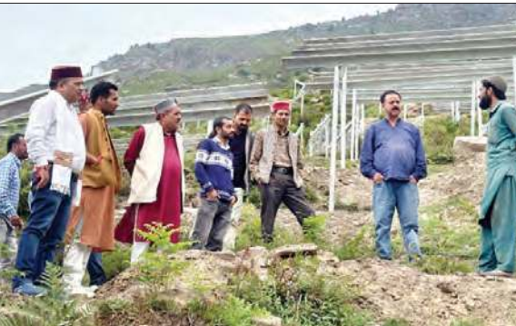
धनवास गांव में निर्माणाधीन मेगावाट सोलर प्लांट का निरीक्षण करते हुए विधायक।
