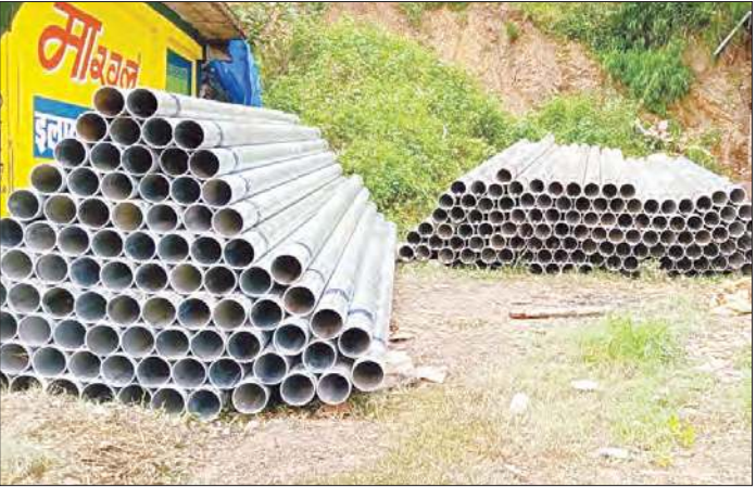
पेयजल व्यवस्था को सुधारने और लीकेज समस्या के समाधान के लिए पानी की लाइन बदलने को खरीदी नई पाइपें।
