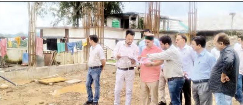
रेत में निर्माणाधीन बीडीओ कार्यालय का निरीक्षण करते उपमुख्य सचेतक एवं विधायक केवल सिंह पटानिया।
