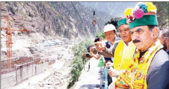
शोंगटोंग-कड़छम प्रोजेक्ट के निर्माण कार्य का जायजा लेते मुख्यमंत्री सुक्खू।
