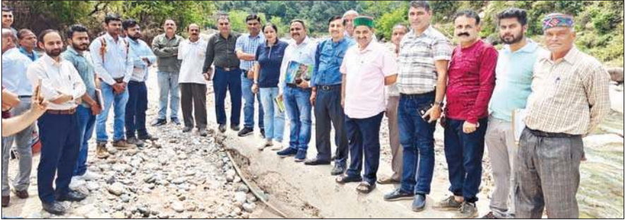
पुहाड़ा गांव में 1.36 करोड़ रुपए की लागत से निर्माणाधीन कूहल का निरीक्षण करते उपमुख्य सचेतक केवल पटानिया।
