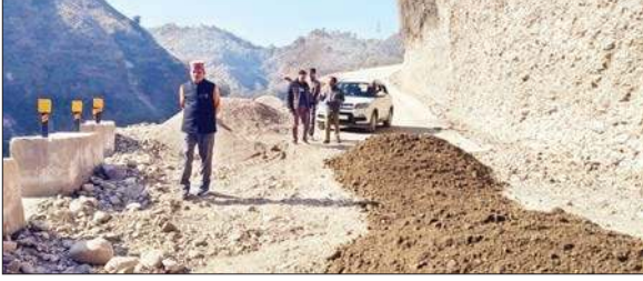
विधायक कैप्टन रणजीत सिंह सड़क के निर्माण कार्य का निरीक्षण करते हुए।
