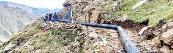
लाहौल-स्पीति में 15000 फुट की ऊंचाई पर सिंचाई के लिए कुछ इस तरह से बिछाई जा रही है पाइप लाइन।
