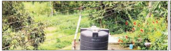
शहर के कई वार्डों में घरों के ऊपर से गुजर रही तारें लोगों के लिए खतरा बन गई हैं। अभी हाल ही में हुई लड़की की मौत के बाद कमेटी बनाई गई है, जो इस पर रिपोर्ट प्रस्तुत करेगी।
