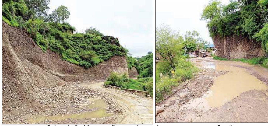
सड़क पर पड़ा मलबा जिसे उठाने की कोई जहमत नहीं कर रहा है, सड़क ने तालाब का रूप धारण कर लिया है।
