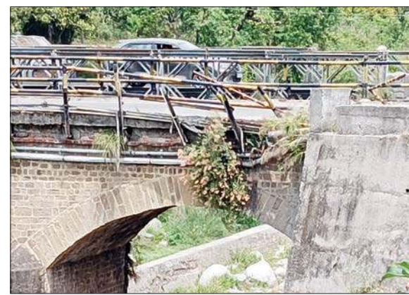
पटानकोट-मंडी राष्ट्रीय राजमार्ग पर स्थित मटौर पुल की टूटी हुई रेलिंग, इससे यहां हर पल हादसे का डर सताता रहता है।
