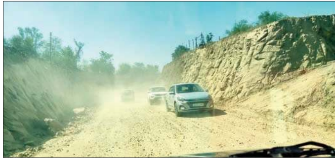
ज्वालामुखी-नादौन फोरलेन निर्माण के चलते उड़ी रही धूल।
