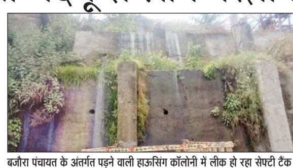
बजौरा पंचायत के अंतर्गत पड़ने वाली हाऊसिंग कॉलोनी में लीक हो रहा सेफ्टी टैंक।
