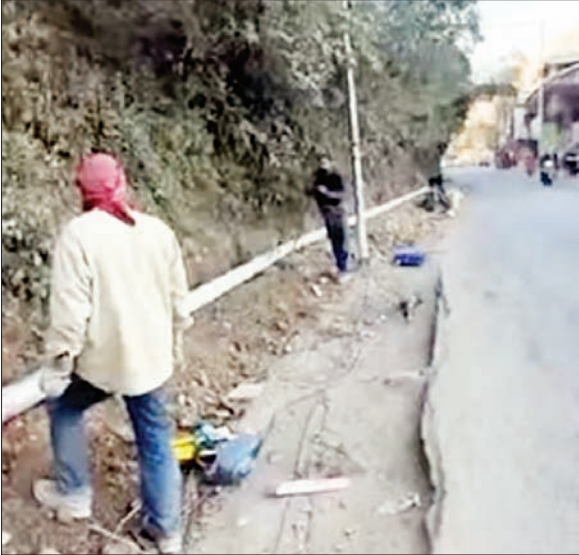
पाइप लाइन बिछाने का कार्य प्रगति पर।
