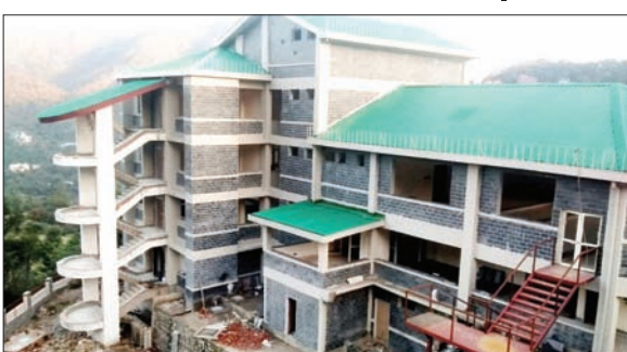
जिला कृषि विभाग का नया बना भवन।
