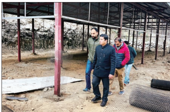
डीसी आदित्य नेगी खेखर में निर्माणधीन गोसदन का निरीक्षण करते हुए।
