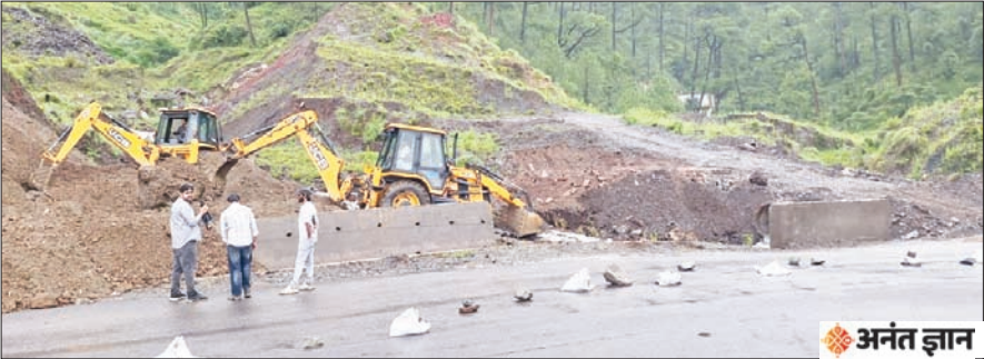
कोटरोपी में क्षतिग्रस्त सड़क के स्थान पर अस्थायी डायवर्जन का निर्माण करती एनएचएआई की मशीनरी।
