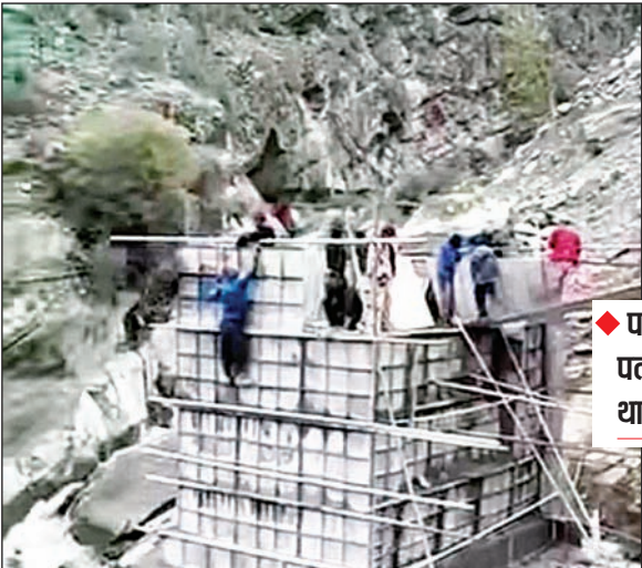
पुल निर्माण में जुटे बीआरओ के जवान।
